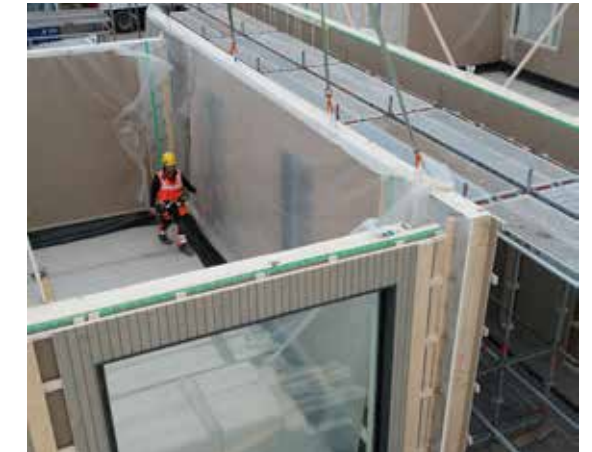
Suurelementit asennetaan suojusti valmiin perustuksen päälle.
