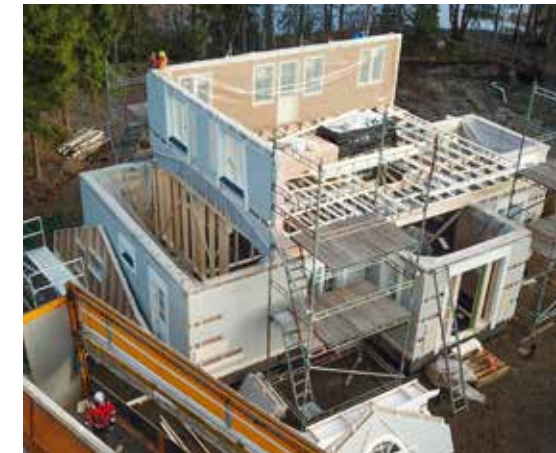
Jetta-Talo asentaa elementit huolellisesti ja ammattitaidolla.
