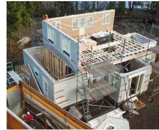
Jetta-Talo asentaa elementit huolellisesti ja ammattitaidolla.
