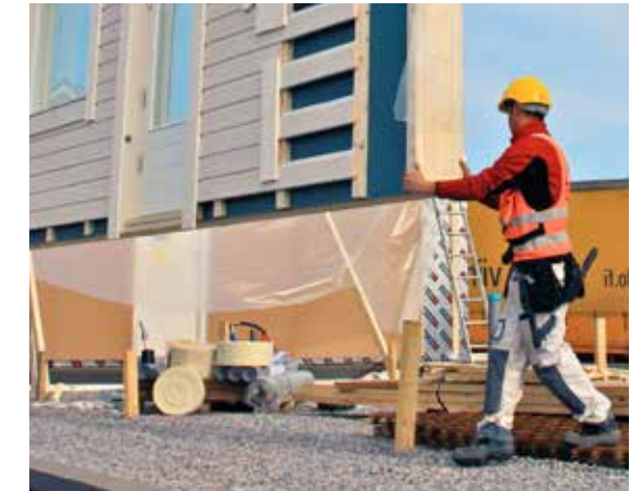
Suurelementit asennetaan suojatusti valmiin perustuksen päälle.
