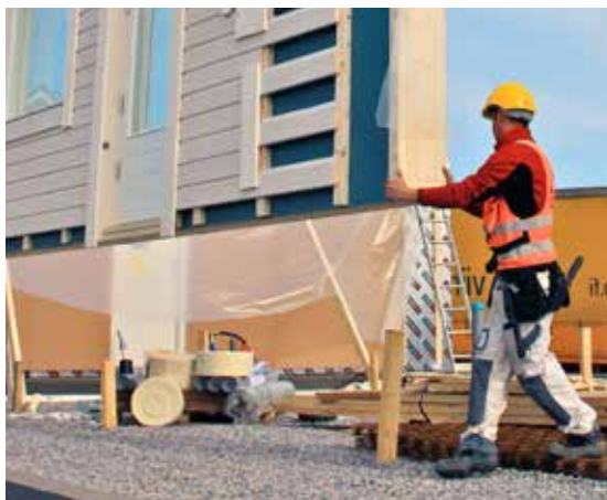
Suurelementit asennetaan suojatusti valmiin perustuksen päälle.
