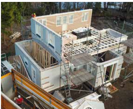
Jetta-Talo asentaa elementit huolellisesti ja ammattitaidolla.
