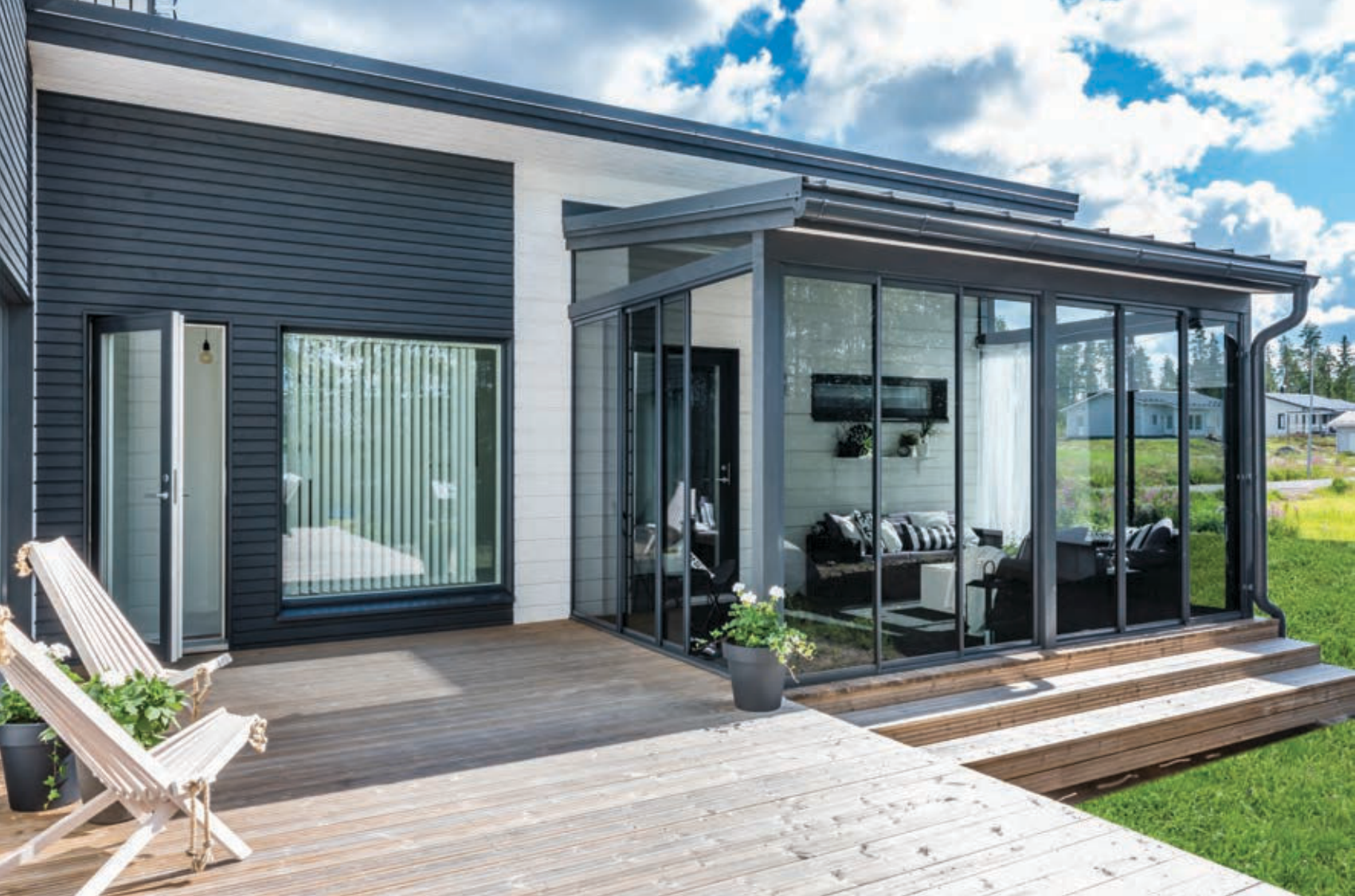
Lasihuone on ylimääräinen oleskelutila, jossa viihdytään varhaisesta keväästä aina myöhäiseen syksyyn saakka. Lasituksen kotiin teki Lasitek.
