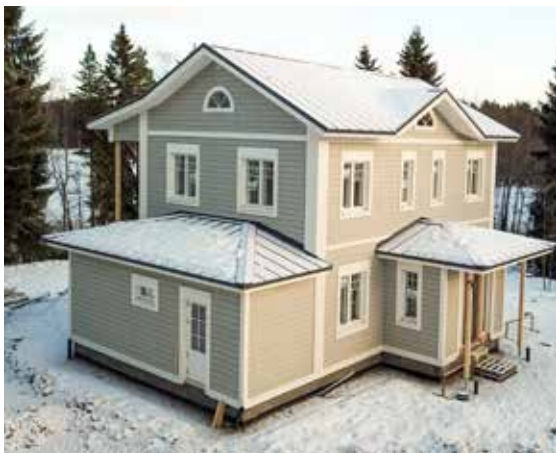
Jetta-Talo är utvändigt färdigt så när som på den sista målstrykningen. Kunden kan direkt fortsätta med inomhusarbeten under kalla vinterdagar.
