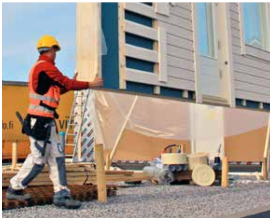
Volymelementen monteras väderskyddade på färdig grund.
